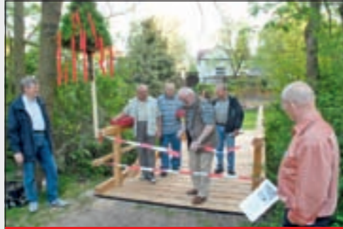
Brückenbau in Eigenleistung: Die neue Brücke über den Rodebach.
