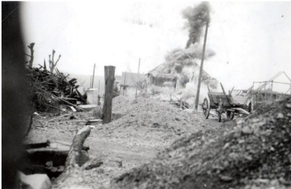
1941 Bombenangriff in Reyershausen
